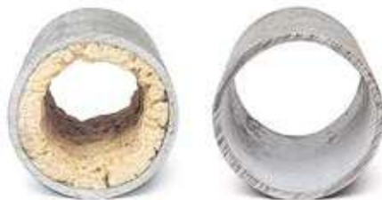
Tubazione prima dell'installazione di Natura h2o
